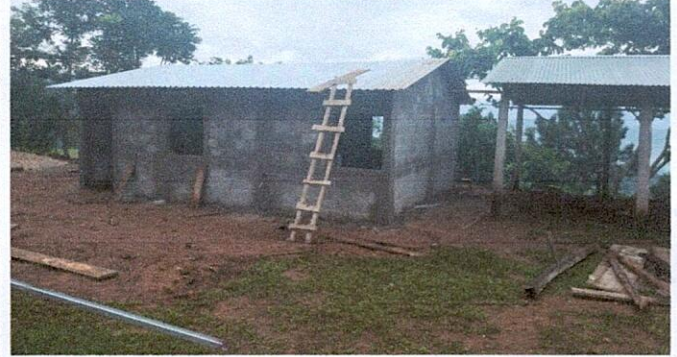
Foto: 2 MEJORAMIENTO MODULO DE AULA TIPO PORTICO, LEVANTADO DE BLOCK Y FUNDICIÓN DE COLUMNAS
