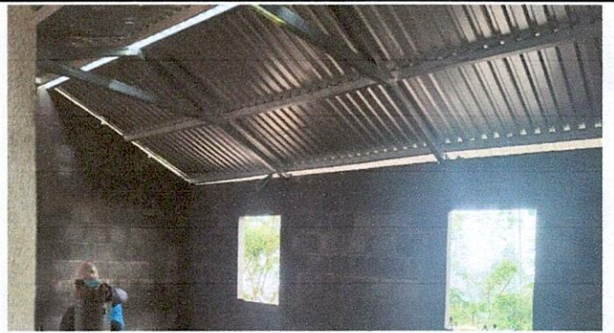
Foto: 4 MEJORAMIENTO MODULO DE AULA TIPO PORTICO, COLOCACIÓN DE LÁMINA TROQUELADA
