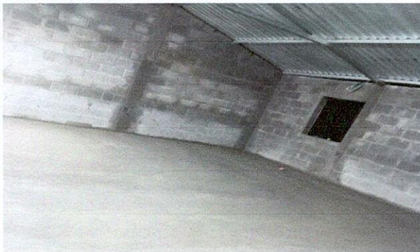
Foto: 3 MEJORAMIENTO MODULO DE AULA TIPO PORTICO, FUNDICION DE PISO
