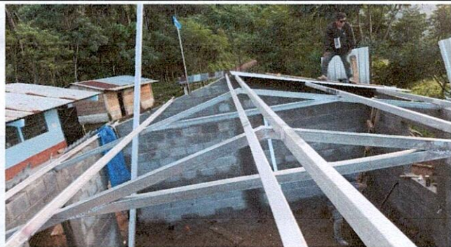
Foto: 5 MEJORAMIENTO MODULO DE AULA TIPO PORTICO, MONTAJE DE ESTRUCTURA PARA TECHO
